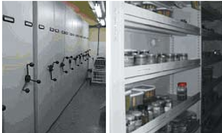
Fig. 7 e 8 – Mobiliário compactador – sistema externo e face interna com guarda-corpo nas prateleiras
